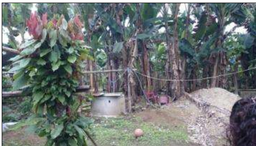
FOTOGRAFÍA 5.7 SITIO DE DISPOSICIÓN DE AGUAS NEGRAS Y GRISES (CUBIERTA SUPERFICIAL DE CONCRETO)
